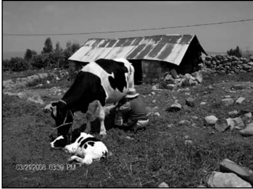
Fuente: la vivienda de piedra y barro de dos filas con mojinetes y tijerales a dos aguas en descomposición estructural por efecto del terremoto del 2001. El entorno hace de establo.
