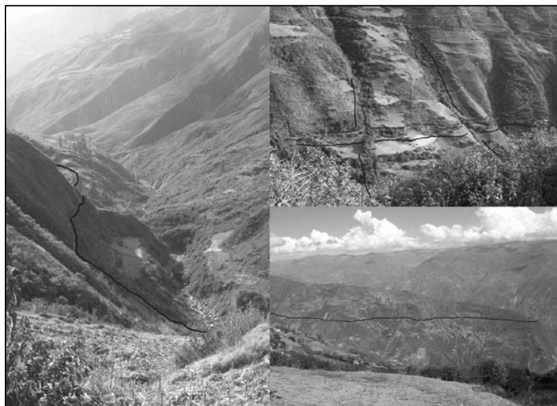
Fig. 9. Vista panorámica del trazo de los canales.
