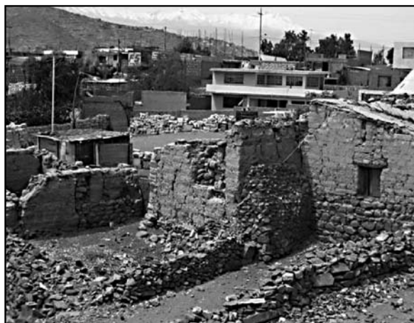
Fuente: vivienda ubicada en la parte posterior de la plaza de Tingo Grande. Archivo particular Arequipa 23 noviembre 2006
