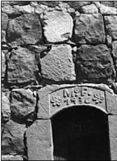
Fuente: Pared frontal de vivienda tradicional en piedra con grabaciones que representa entre rosetones la fecha de construcción e inauguración de la familia de Mariano Flores, con techo de calamina a dos aguas. Mosopuquio – Characato – Arequipa.
